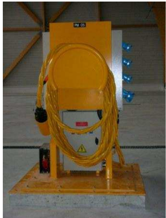
Câbles 400 Hz sur loveur
